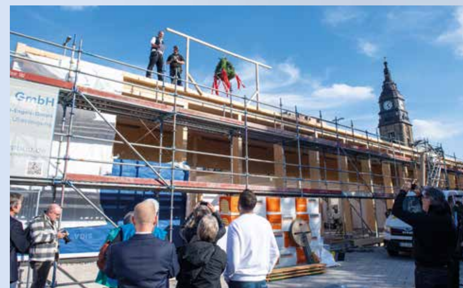
Richtfest der neuen Bahnhoftsmission Hamburg, 4. Oktober 2022
